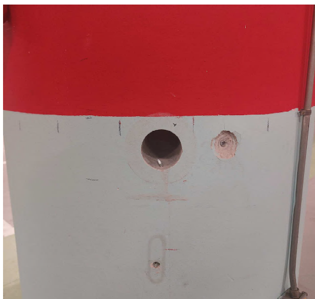
Carotaggio preliminare per progetto antisismica.
