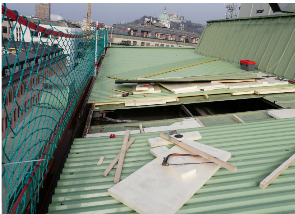
Operazioni di isolamento del tetto.
