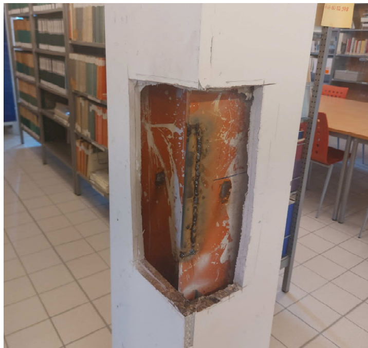
Rilievo preliminare per progetto antisismica.
