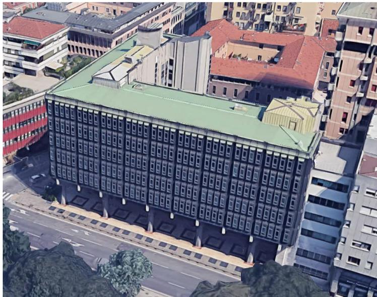
Le facciate principali dal piano primo al quinto sono formate da componenti modulari dove hanno sede gli infissi oggetto dell'intervento. Questi infissi sono stati sostituiti nel 2003 ed hanno vetri isolanti con trasmittanza termica attestata tra 1.9 e 2.1W/m<sup>2</sup>K (dati da diagnosi energetica). Sono dotati di schermature solari costituite da tende scorrevoli tipo veneziana color nickel, poste all'interno degli ambienti.
