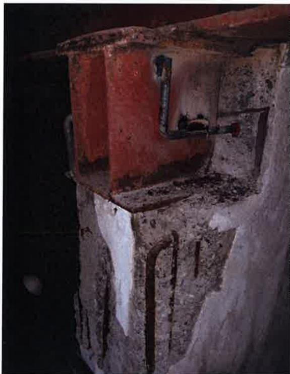
Anche un altro sostegno in c.a. mostra crepe analoghe. Il distacco dell'intonaco ha portato alla luce i ferri di armatura quindi ho contattato l'impresa edile che farà un sopralluogo nei prossimi giorni per concordare un ripristino dello strato di "copriferro" con una malta adeguata.
