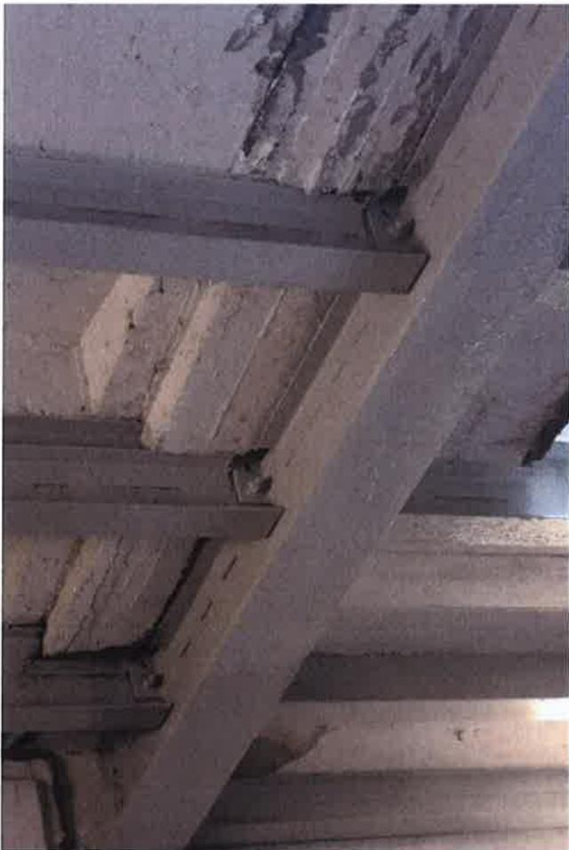
Nello spazzolare e ripulire le travi per la successiva vernicitura si è distaccato l'intonaco di due mensole in cemento armato che sostengono il trave dell'orditura principale che porta il grigliato carraio. Le mensole si trovano in corrispondenza al primo portone motorizzato.
