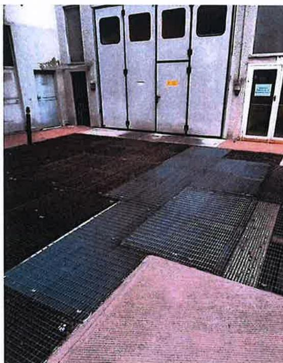
Le griglie, oltre a non rispondere più allo standard per la carrabilità del solaio, mostrano in questi ultimi giorni nuovi ulteriori strappi di alcune maglie che, con il transito delle autovetture, potrebbero cedere in diversi punti. Tali cedimenti potrebbero provocare la lacerazione dei pneumatici, con il pericolo, oltre che di danneggiamento dell'autovettura, anche di incidenti in un tratto che svolge anche la funzione di via di fuga pedonale della sala di pubblico spettacolo - auditorium.
