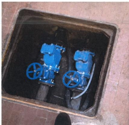
La funzionalità delle pompe è stata quindi completamente ripristinata con la loro sostituzione e delle rispettive valvole di ritegno. Si sono conclusi anche i lavori di ripristino dei serramenti, muri e lampada in auditorium.
