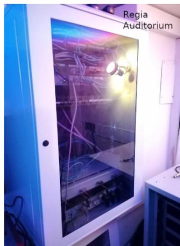
Propongo pertanto la sostituzione dei 5 switch guasti e di altri tre di pari età, la contemporanea rimozione dei cavi telefonici analogici compreso il riordino e la codifica dei cavi delle permutazioni tra switch e patch-panel. Tale intervento richiede la presenza dei colleghi dei servizi ICT e dell'elettricista. Ogni switch verrà preventivamente configurato dal sistemista nell'ambito della sua attività contrattuale.
