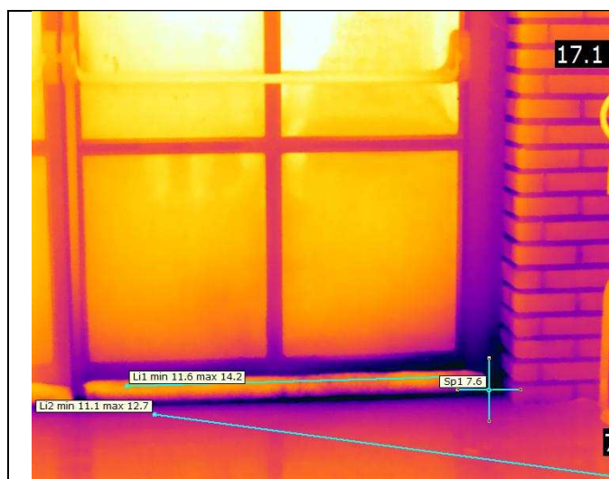
Dispersioni serramenti est zona padiglione 10
