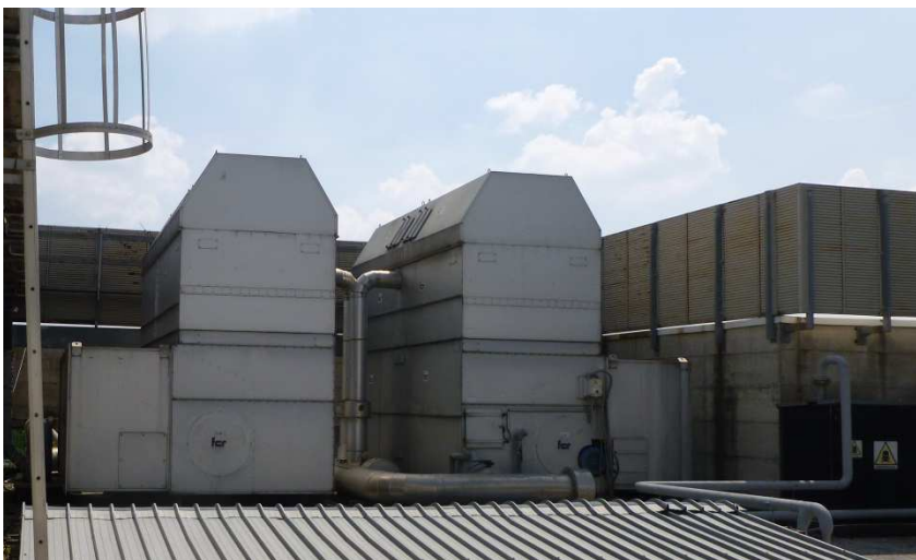
torri evaporative esistenti
